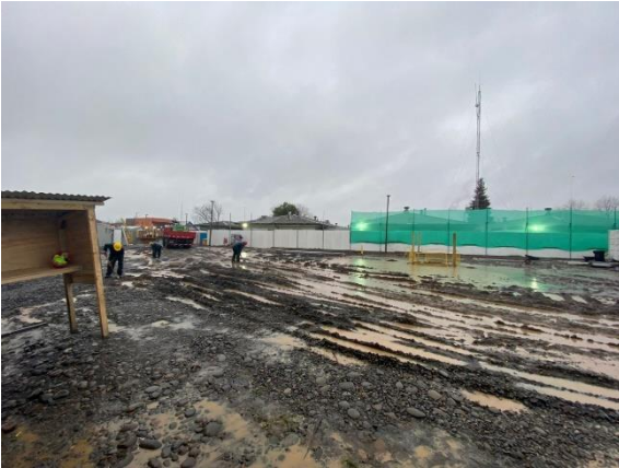
Área central del Hospital de Nacimiento. Trabajos de Limpieza de terreno.
