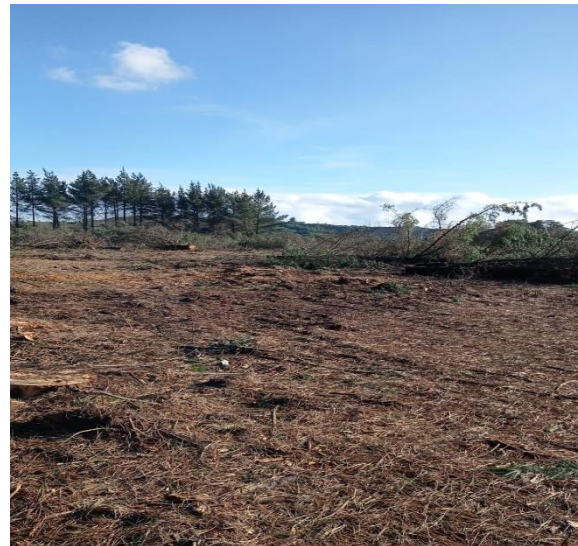
Trabajos de descapote. Hospital de Coronel.
