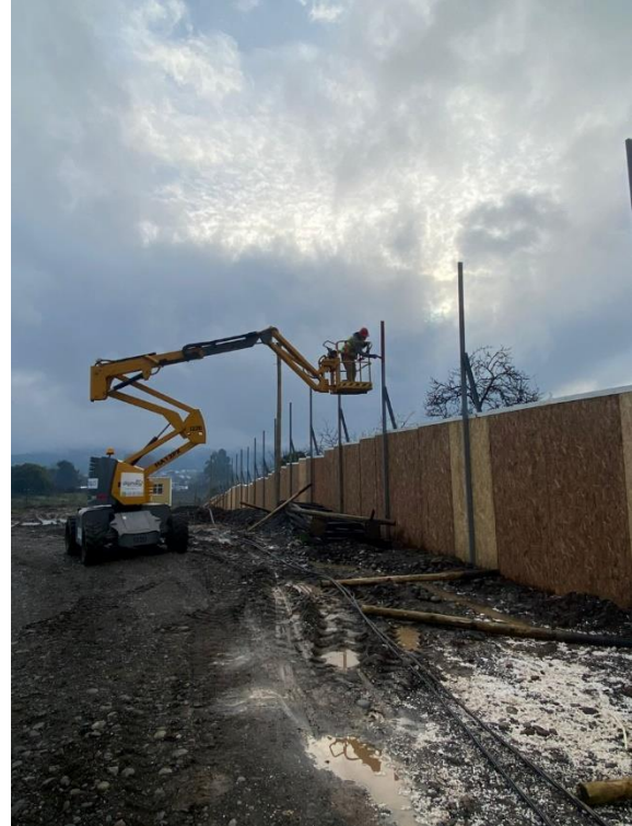
Hospital de Nacimiento. Cierre perimetral
